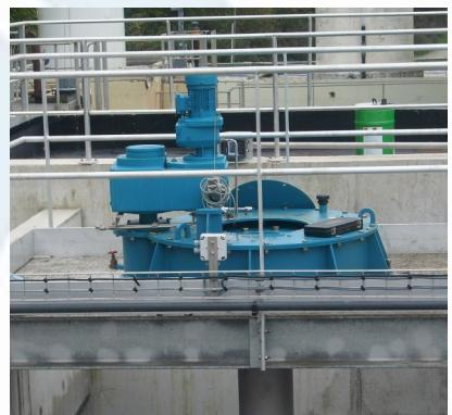
L'équipement peut être complété par des systèmes de lavage automatique, un contrôle de niveau et une instrumentation de suivi. Sa conception modulaire et ses équipements en inox garantissent une intégration aisée dans tout type d'ouvrage, neuf ou en réhabilitation.
